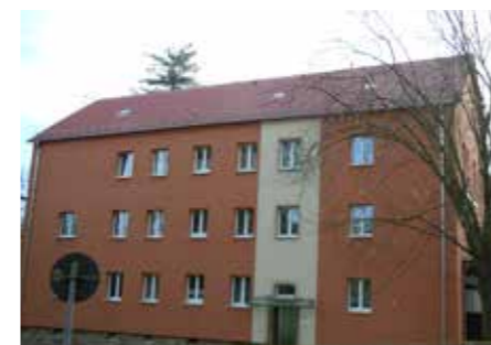
Dachsanierung, Am Stieglitzberg 1 – 3
